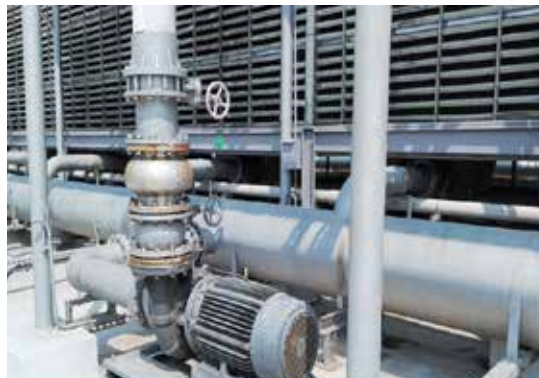
提高能源使用效率以達到落實節約能源，廠內空調冰水幫浦汰舊換新。
