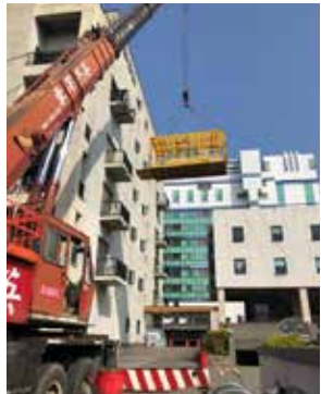
設備吊掛作業
