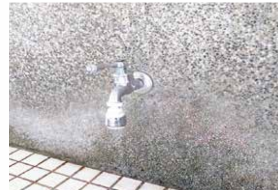
進行洗手台節水器安裝，落實節約用水。
