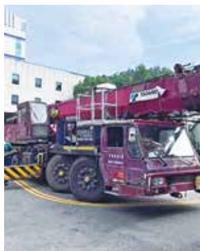
產線設備吊掛作業
