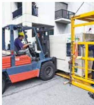
設備搬運作業
