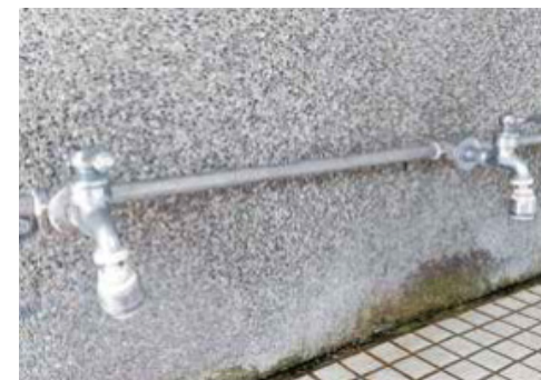
(圖) 進行洗手台節水器安裝，落實節約用水。
